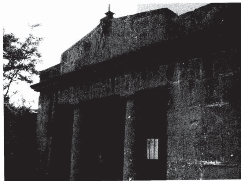
M. LOVATTI (1819), il pronao della chiesetta di Santa Maria dell'Acquasanta a Marino (particolare)
